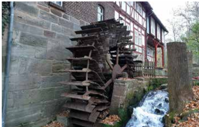
Ansicht der Hohlebachmühle in Homberg (Foto: EKS)
